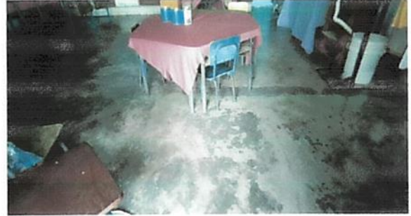
Foto 2: Instalacion de piso
