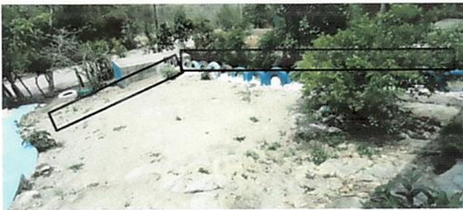
Foto 5: muro perimetral de piedra
