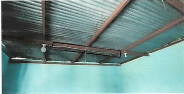
Foto 3: Reparacion del sistema electrico
