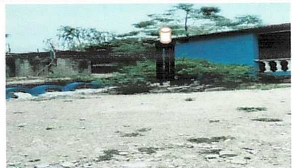
Foto 6: Suministro e Instalacion de tanque de agua
