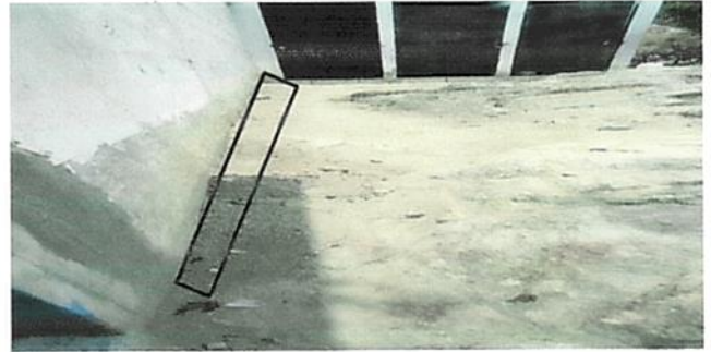
Foto 4: reparacion de muro perimetral de mamposteria
